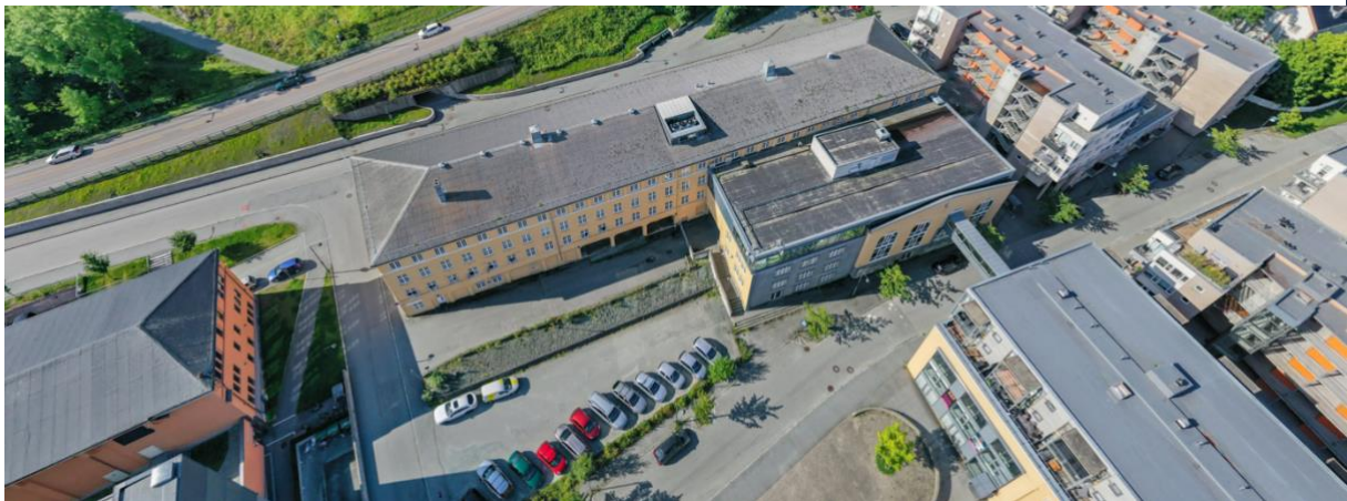
Figur 4-12. Mellomila 79-81 før transformasjon, som tomt industri- og kontorbygg. Fastout.com (2021)
