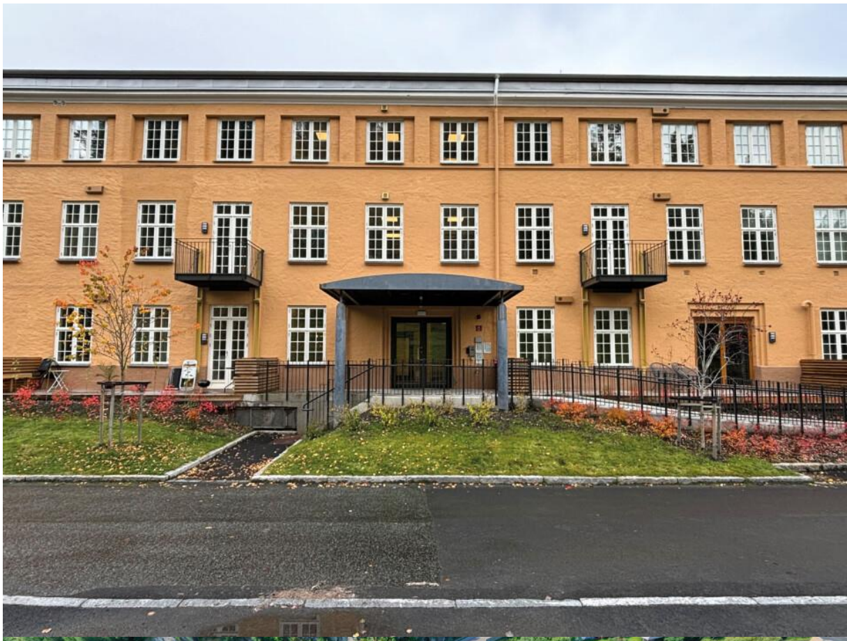
Figur 4-11. Ilsvika Vest ferdig prosjekt, fasade mot baksiden med rehabilitert industribygg.
