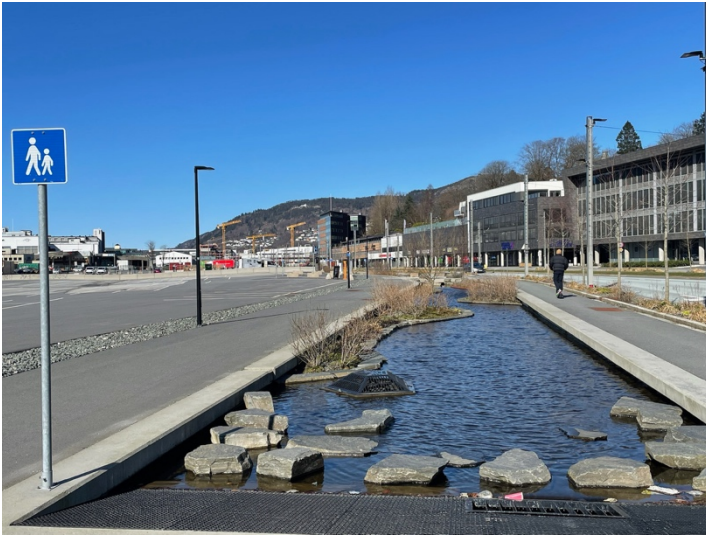
Bilde 4: Kanal med tilhørende gangvei som er etablert. Kilde: eget foto.
